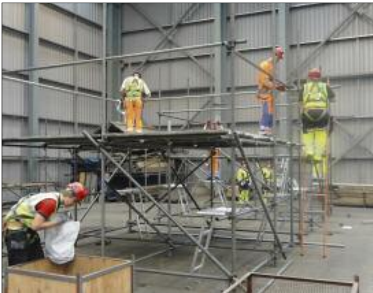
LÆRTE STILLASBYGGING: TAF-elevene ved Verdal videregående skole lærte både å sette sammen stillas og om sikkerhet rundt bruken av stillas. Foto: Verdal videregående skole
